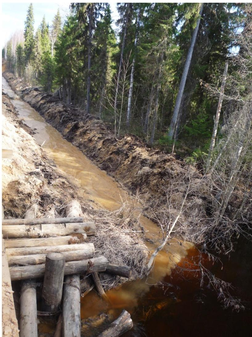
Рисунок 5. Протяженная прямая канава без инженерных средств снижения эрозии заполнена смытым песком. Весенние паводки выносят взвесь в русло.
