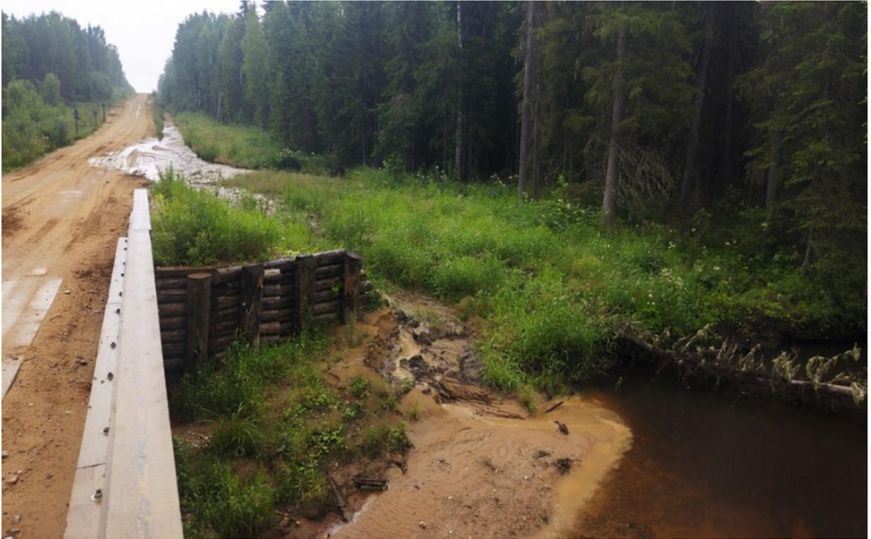
Рисунок 1. Кратковременный дождь и вынос взвешенных частиц в водоток.
