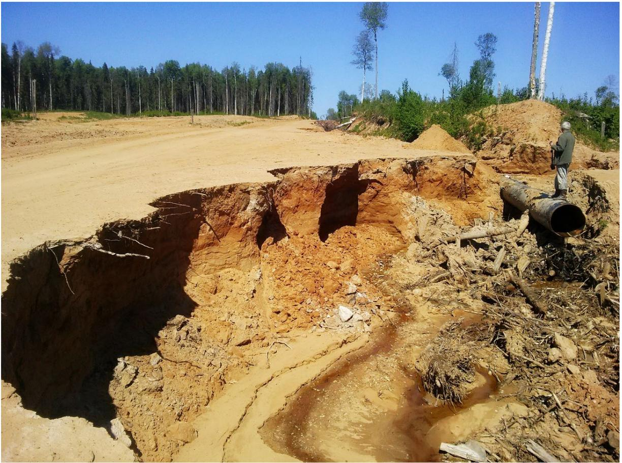
Рисунок 8. Участок дороги, неоднократно размывый водой вследствие неправильного размещения водопропускной трубы.
